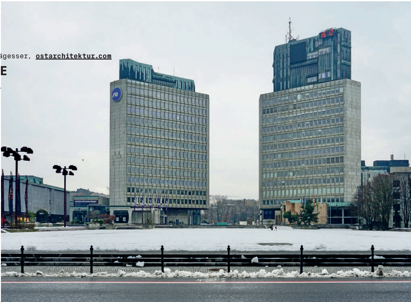
Platz der Republik mit den beiden dreieckigen Hochhäusern TR2 und TR3.
