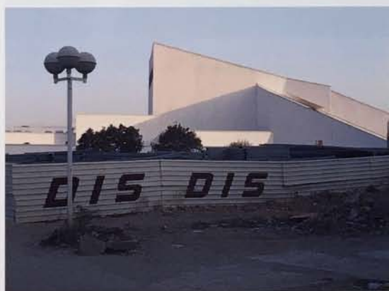
6 Makedonská opera a balet, architekti Biro 77, realizace 1979; zdroj: archiv autora.
